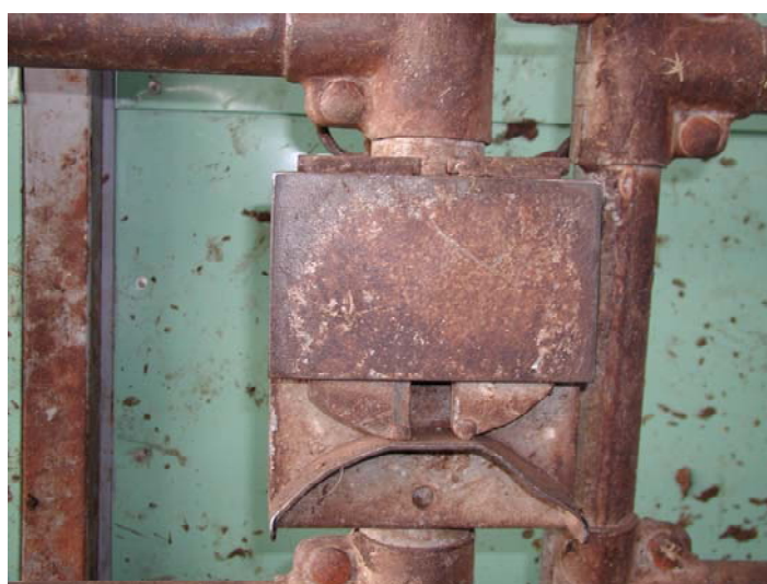
写真1 ゲートロックを正面から見たところ
