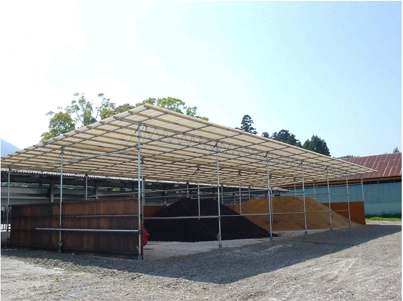
写真1 簡易堆肥舎全体
