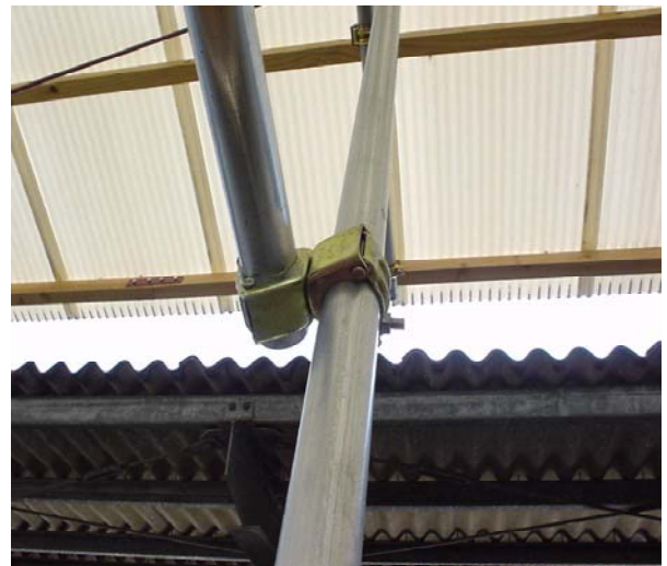
写真3 足場パイプの接続
