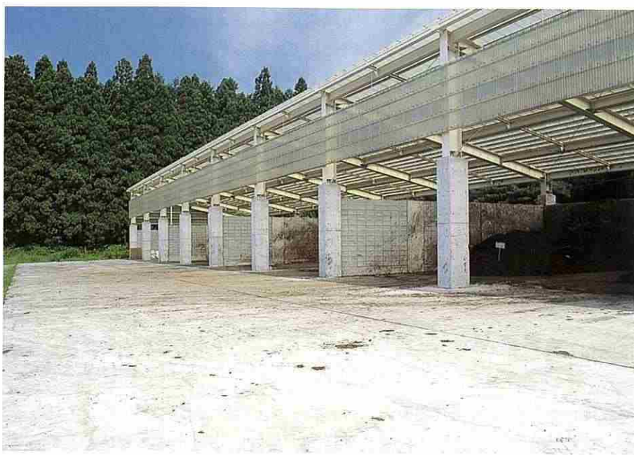
写真 3 堆肥舎の全景
