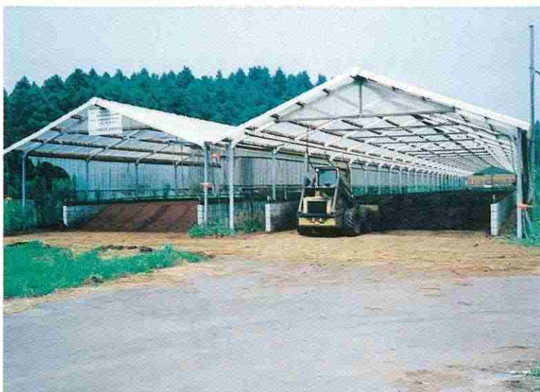
写真7 2槽式発酵堆肥舎
