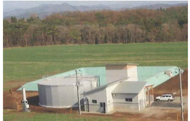
メタン発酵処理施設 (バイオガスプラント：岩手牧場) メタン発酵で生じるバイオガス (CH 4 濃度約 60%) を熱源として循環利用することにより CH 4 の排出を低減。
