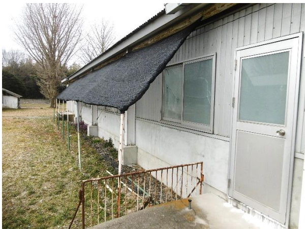
寒冷紗の設置
