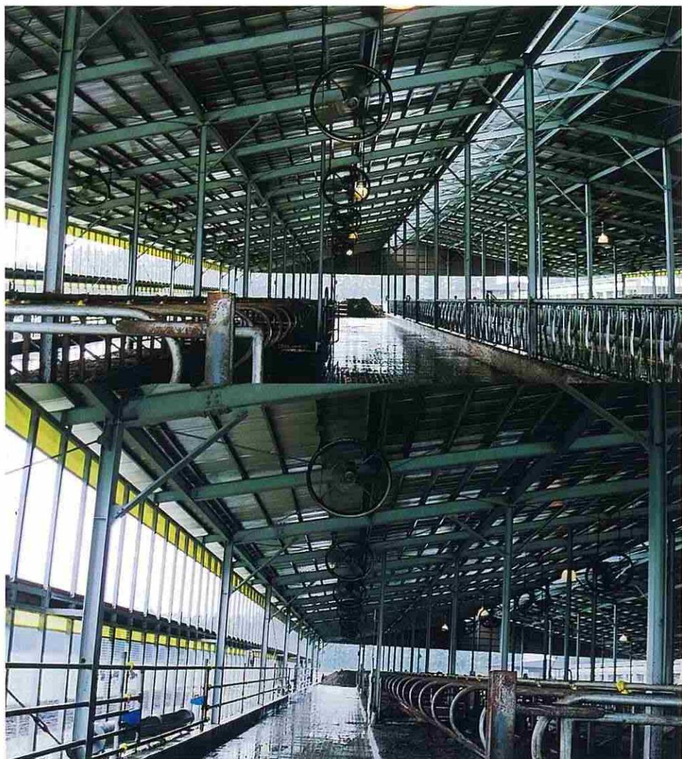
写真20 懸垂型換気扇の設置位置
