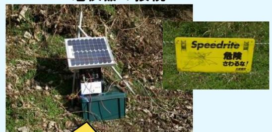
アース棒をしっかりと打ち込む。接続後、バッテリーチェッカーで電圧を確認。危険表示板を設置。
