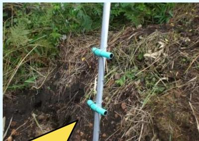
約5～10m間隔に支柱を打ち込み、漏電防止用のゴムホースを地上約50cmと約90cmに取り付ける。
