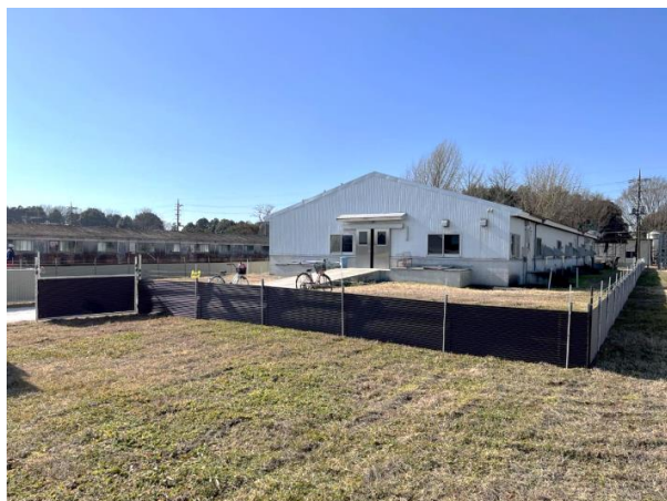
子豚豚舎のフェンス設置状況
