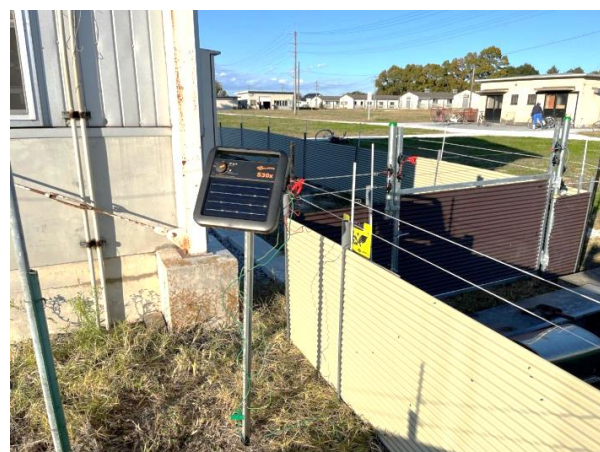
ソーラーパネルと電気柵(ガラガー S60x)
