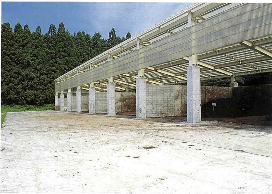
写真3 堆肥舎の全景
