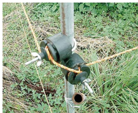
<漏電防止のためガイシを2個設置>
