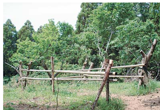
<杭を打ち孟宗竹を針金で縛り付け>
