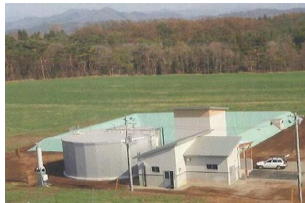
メタン発酵処理施設(バイオガスプラント：岩手牧場) メタン発酵で生じるバイオガス(CH 4 濃度約60%)を熱源として循環利用することによりCH 4 の排出を低減。
