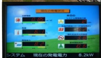
太陽光発電システム(熊本牧場)
