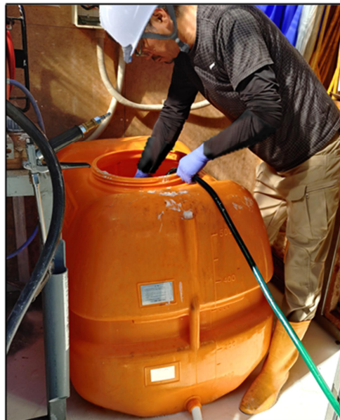
写真3：定期的にタンク内の粉を除去し、水洗
