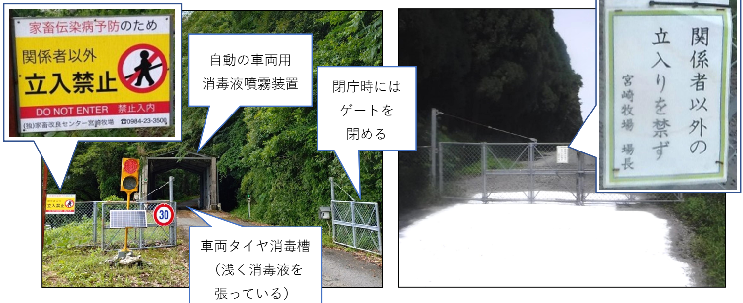
写真2：常時ゲートを閉めている入口の様子 (消石灰帯を敷設することで、消毒効果だけでなく、視覚的に管理区域であることが分かりやすくなる効果が期待できる)
