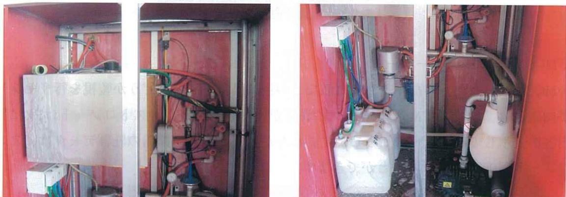
キャビネット内にはバキュームポンプ、洗浄水タンク等が設置されています。バキュームポンプは搾乳に必要な真空圧を作り出すための装置です。洗浄水タンクは、ミルカーからバルクタンクまでのミルクのラインを洗浄するための湯を沸かして溜めておくための装置です。アストロノートは搾乳施設としては比較的小規模な構造であり、付随機器もシンプルでコンパクトになっています。
