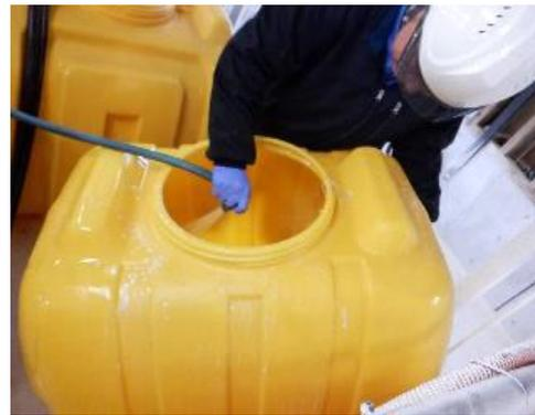
写真 14<タンク内の水洗>
