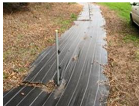
写真4 電気柵下の防草シート敷設
