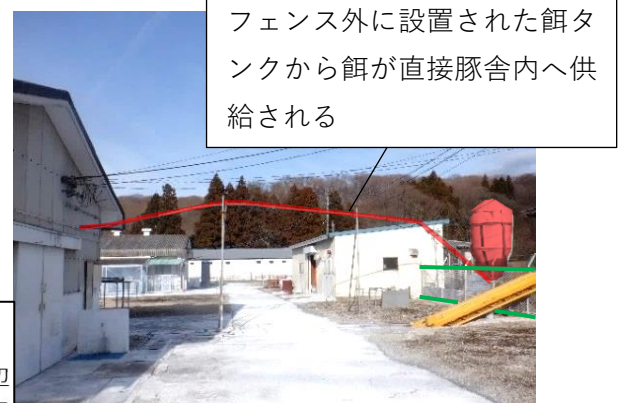
写真9 各豚舎への餌の輸送パイプ
