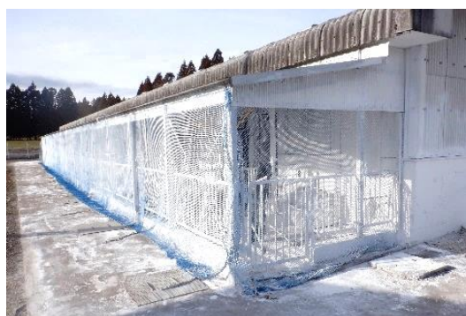
写真 11 防鳥ネットの設置
