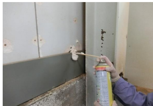
写真 12 ウレタンフォームによる穴の充填
