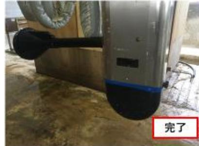
吸引センサーのカバーを取り付け、保温材を結束バンドを使用し元の状態に戻す。最後に蓋を取り付けて終了。
