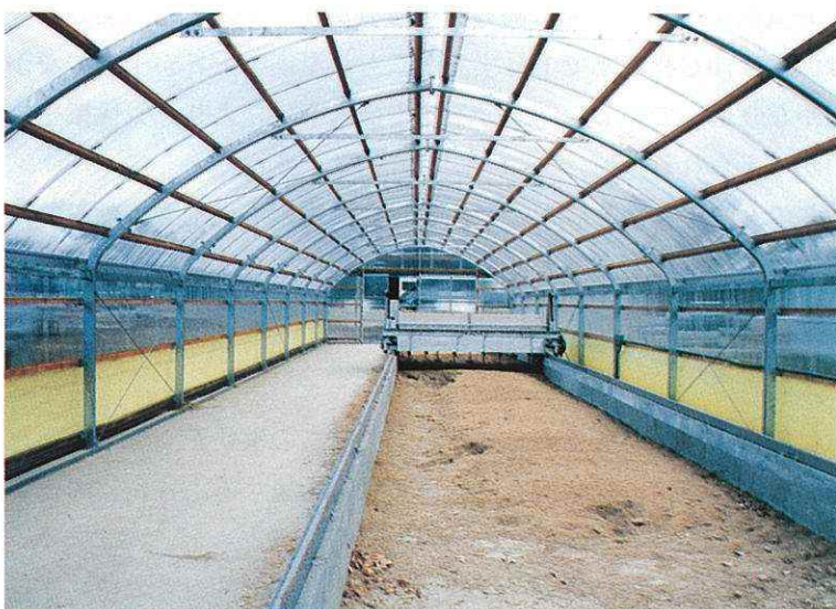
写真8 軽量鉄骨ハウス
