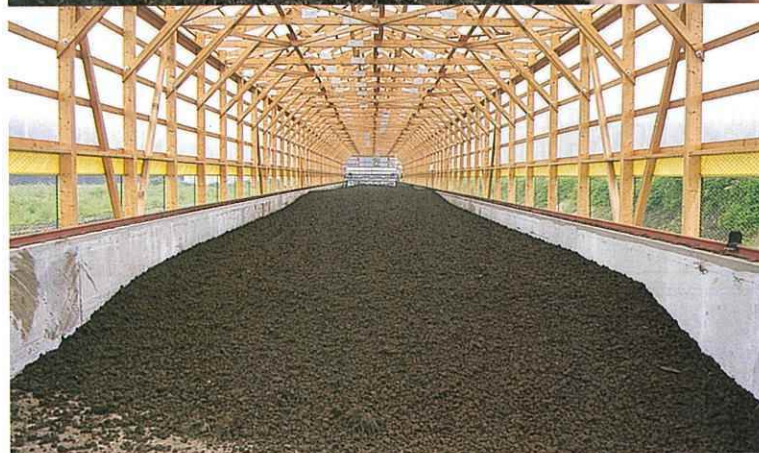
出口から見た発酵槽の全景
