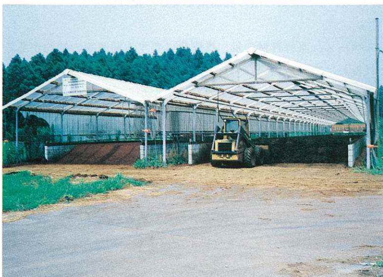
写真7 2槽式発酵堆肥舎
