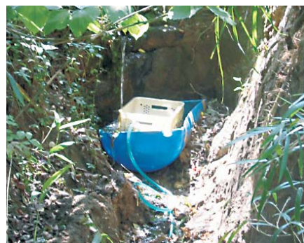
<ドラム缶を利用した貯水タンク>
