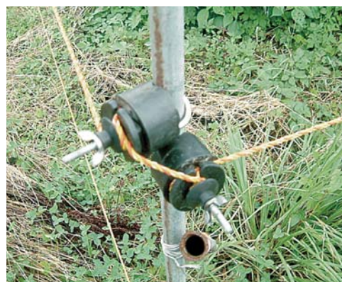
<漏電防止のためガイシを2個設置>
