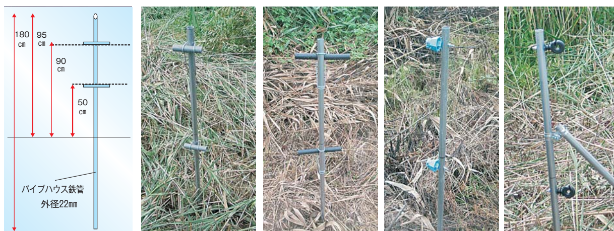
パイプハウス支柱の寸法
